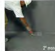
Aplicación de la 2ª mano de HIDROELASTIC.
