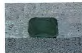
Colocar embutido en hormigón.
