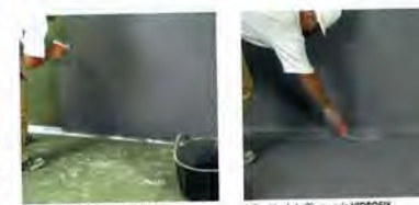
Aplicación de la 1ª mano de HIDROFIX .
