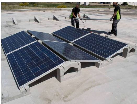
IL·LUSTRACIÓ 9. DISPOSICIÓ PLAQUES SOLARS
