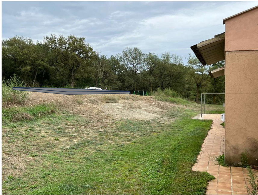
IL·LUSTRACIÓ 12. FOTOMUNTATGE DE LA SOLERA DE FORMIGÓ
