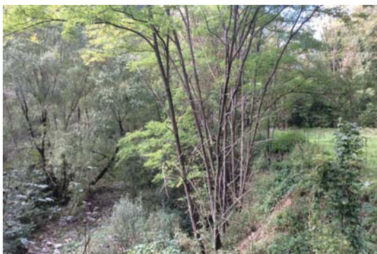
Actuació RIGRib.01: Eliminació d'invasores i estabilització del talús
