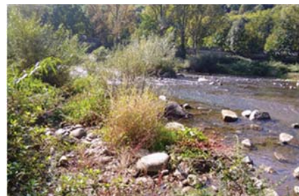
Actuació SOLANA.04 - Construcció d'un raspall per a la protecció d'una plantació de verns en la riba.
