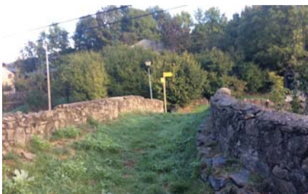
10. Accés caminant des del barri de Les Casetes cap la zona
