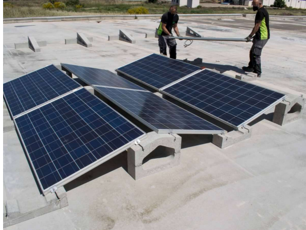
Il·lustració 3. Exemple del sistema de fixació Solarbloc Est-Oest
