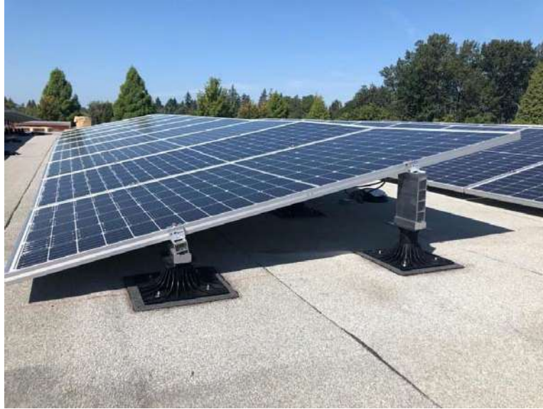
Figura 10: Estructura triangular sobre coberta TPO a utilitzar
