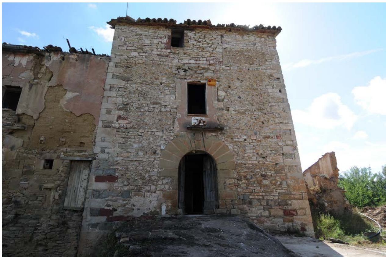
Façana oest, la torre del segle XVI, amb el portal, finestra trífora, molt alterada, i traces del matacà superior.
