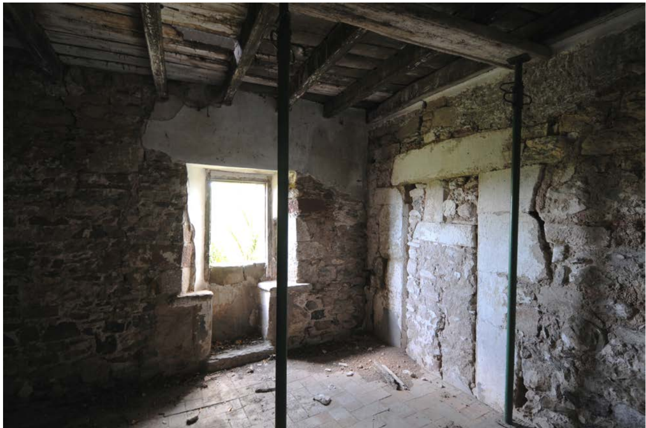
Sala del primer pis, amb una porta del segle XVII, paredada arrel de l'ensorrament de l'angle nord est del Mas.
