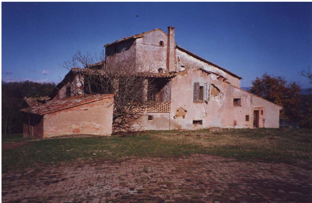
La façana sud, amb la solana, el 1998, a l'inici de les obres.
