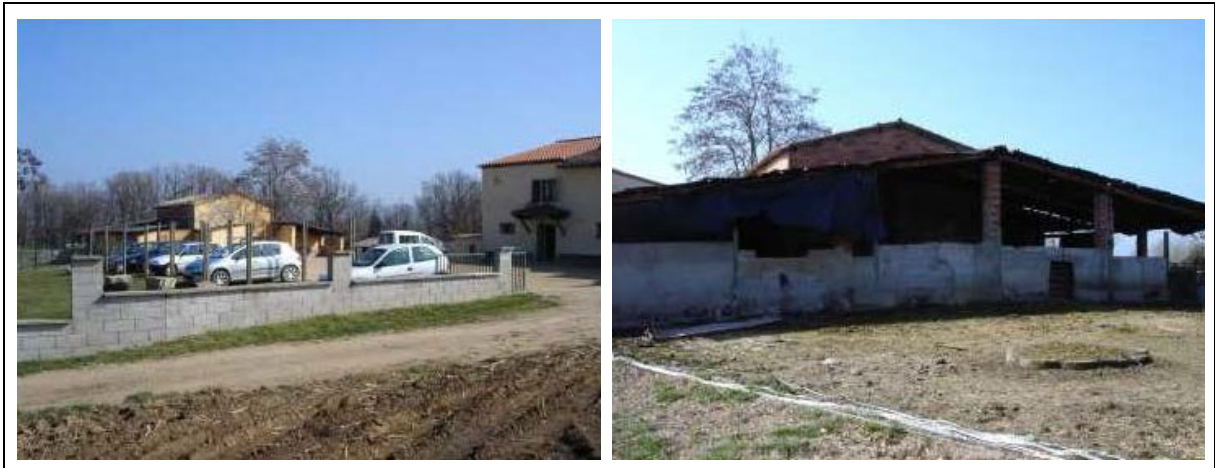
annex 1 tal com consta al Catàleg, estat previ a l'enderroc dels coberts laterals
