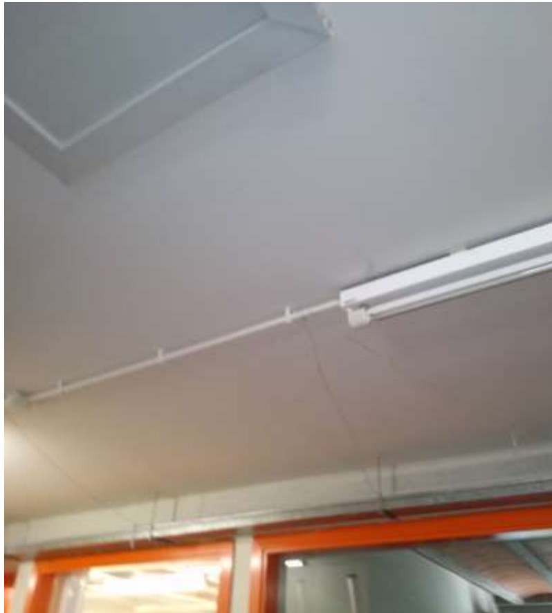
Fig. 6 Baixada sala tècnica terrat fins a safata de cablejat
