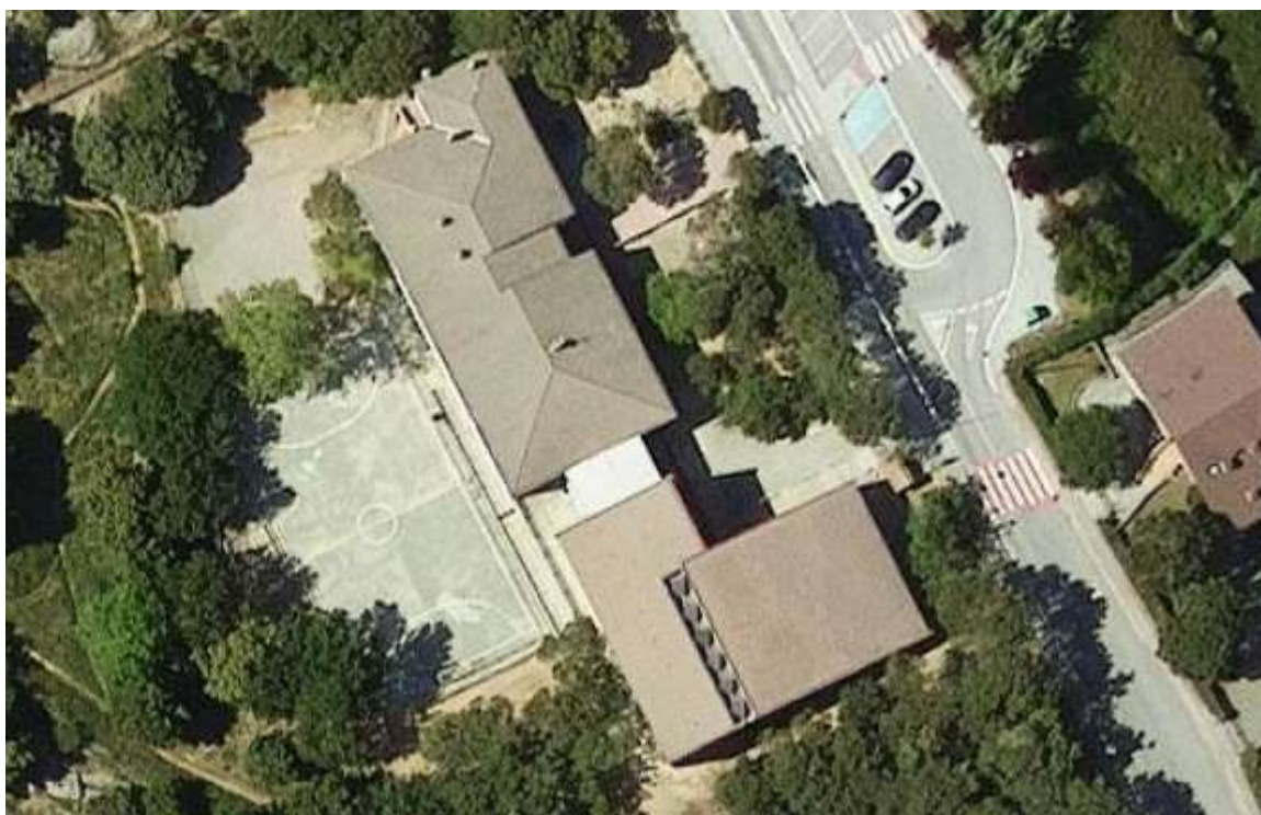
Fig. 1 Ubicació instal·lació fotovoltaica
