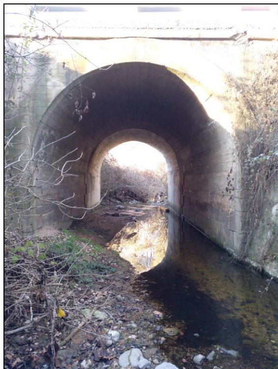
Figura 10: Estat actual, pont sota la carretera BV-5306
