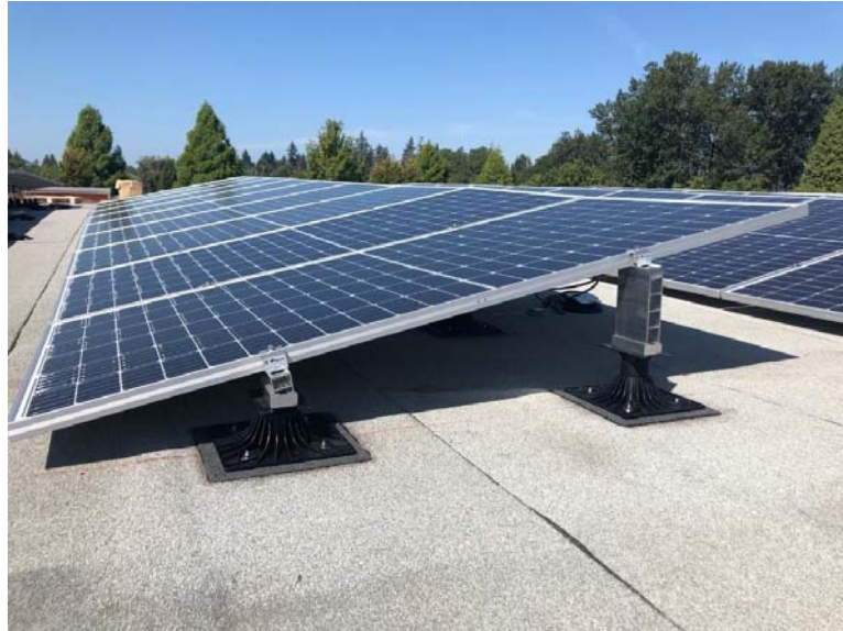
Figura 10: Estructura triangular sobre coberta TPO a utilitzar
