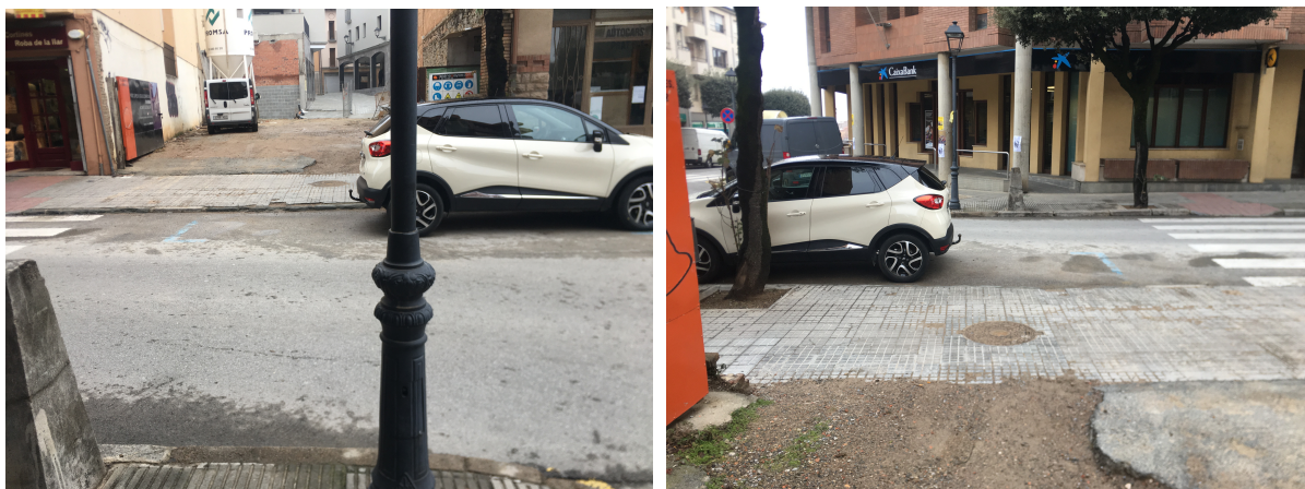
Vista des de cada costat al futur vial comercial (en construcció) amb el pas mal ubicat.
