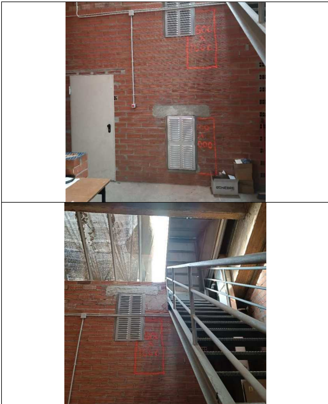
Imatge 2 Fotografies de l'espai on s'ubicarà l'inversor
