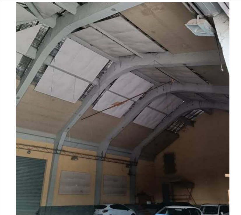
Imatge 3 Fotografies de l'estructura de la coberta de l'edifici
