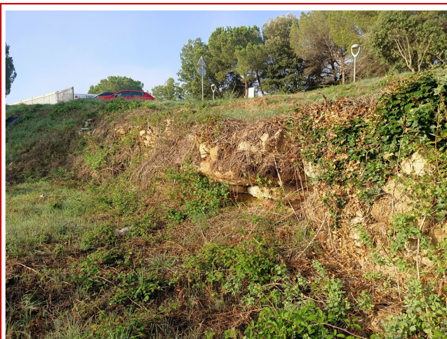
Fotografia 5 – Aflorament dels substrat resistent el talús posterior a la zona a edificar.
