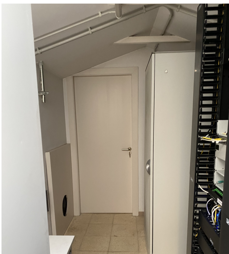
Punt d'ubicació del nou mòdul per a l'inversor i quadres de protecció CC i CA, sala del rack (penjat a paret existent de l'esquerra, sobre del forat de ventilació)
