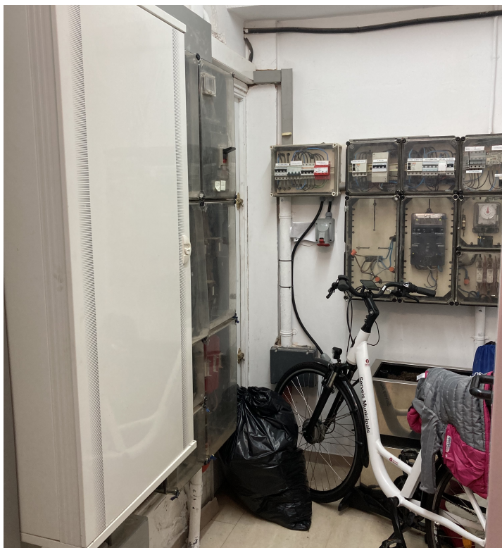
Sala del quadre general i comptadors on es farà la connexió final d'ela instal·lació
