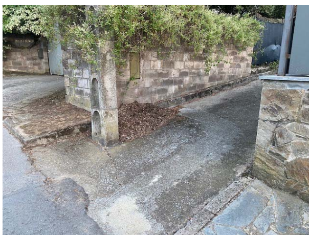
Situació del nou quadre elèctric
