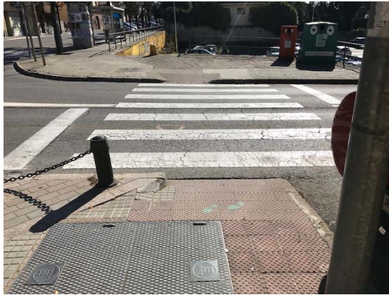
Gual descentrat del pas de vianants en la Carretera Mont-rodon
