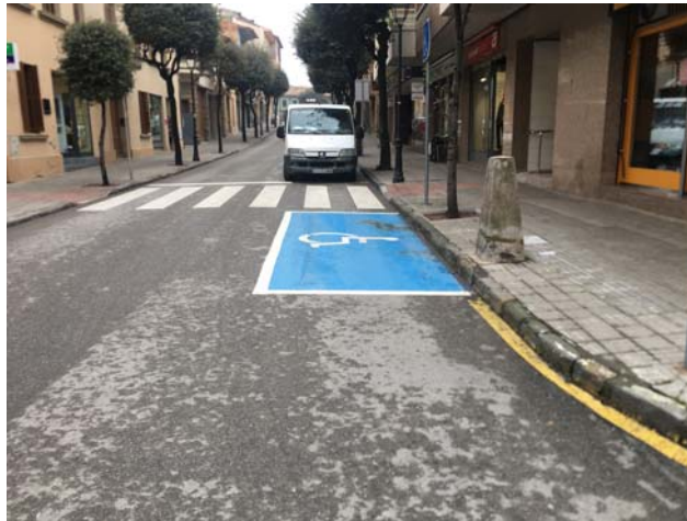
Vista al pas de vianants amb mala visibilitat i mal ubicat.
