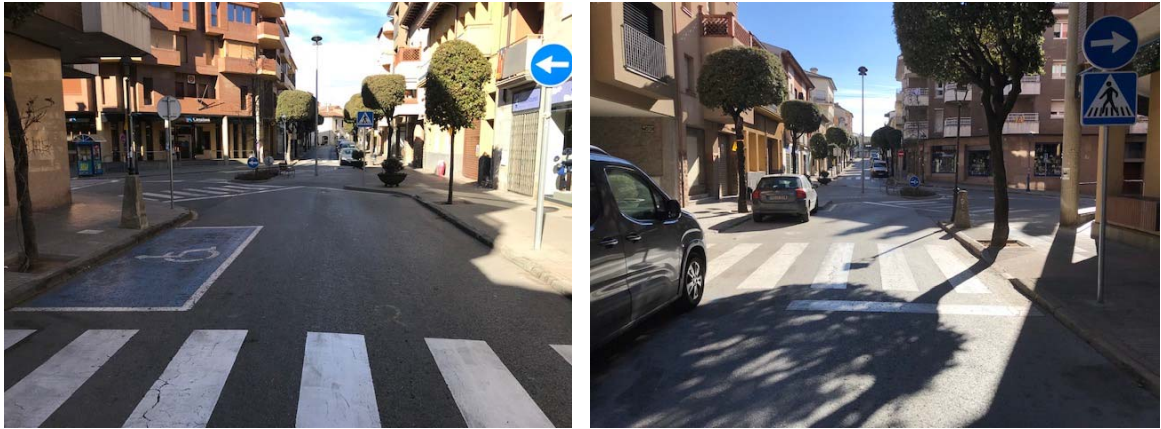
Vista a l'accés a la cruïlla amb el Passeig Domènec Sert
