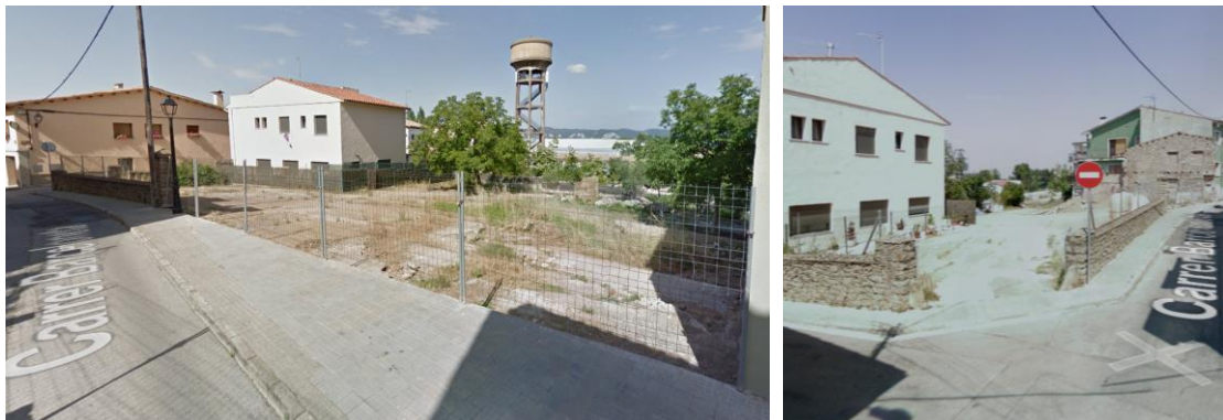
Imatges de l'estat actual
