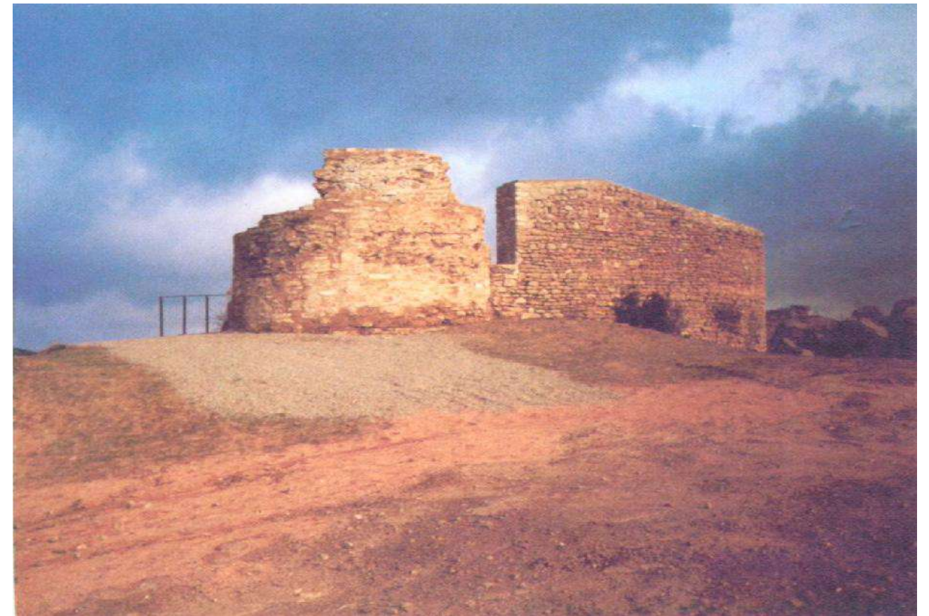
Figura 50. Torre restaurada, 1989 (Caballé i Ollich, 1989).
