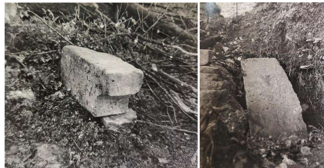
Figura 31. Descobriment d'un permòdol o mènsula pètria i de la possible llinda del portal. Arxiu del Servei de Patrimoni Arquitectònic de la Generalitat de Catalunya.
