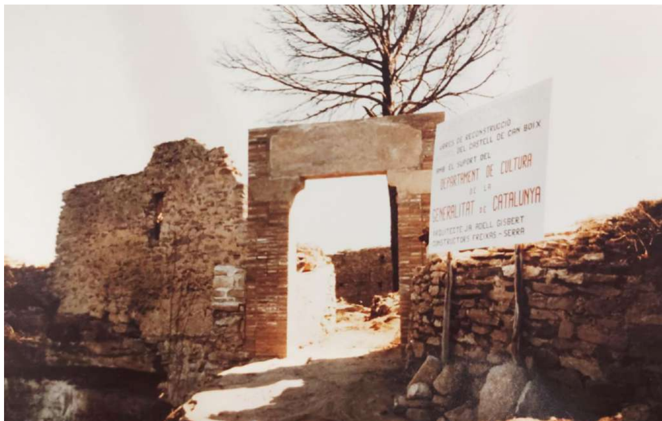
Figura 41. Fotografia del portal acabat. Font: Arxiu del Servei de Patrimoni de la Generalitat de Catalunya.
