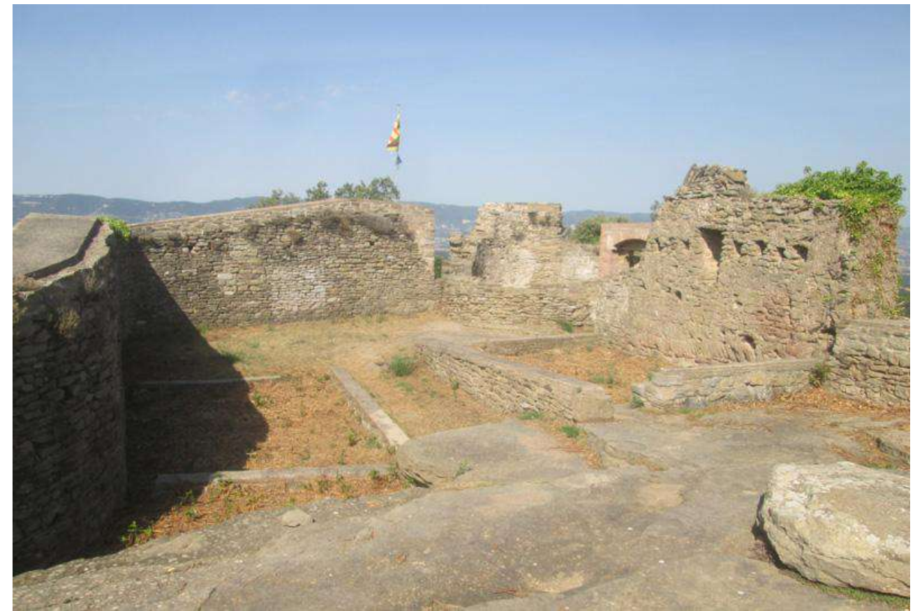
Figura 58. Vista interior a ponent. Font: Fitxa de la Diputació de Barcelona.
