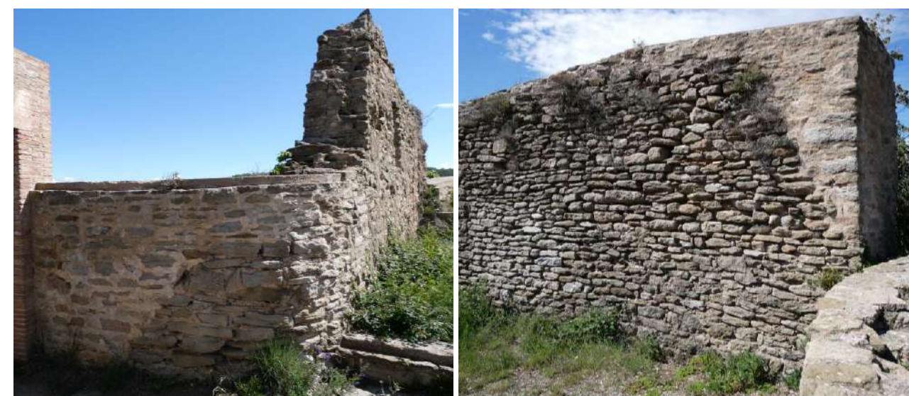
Figura 87. Cantonada interior entre el portal i la capella (a) i mur oest (b) respectivament (EMG, 2024).
