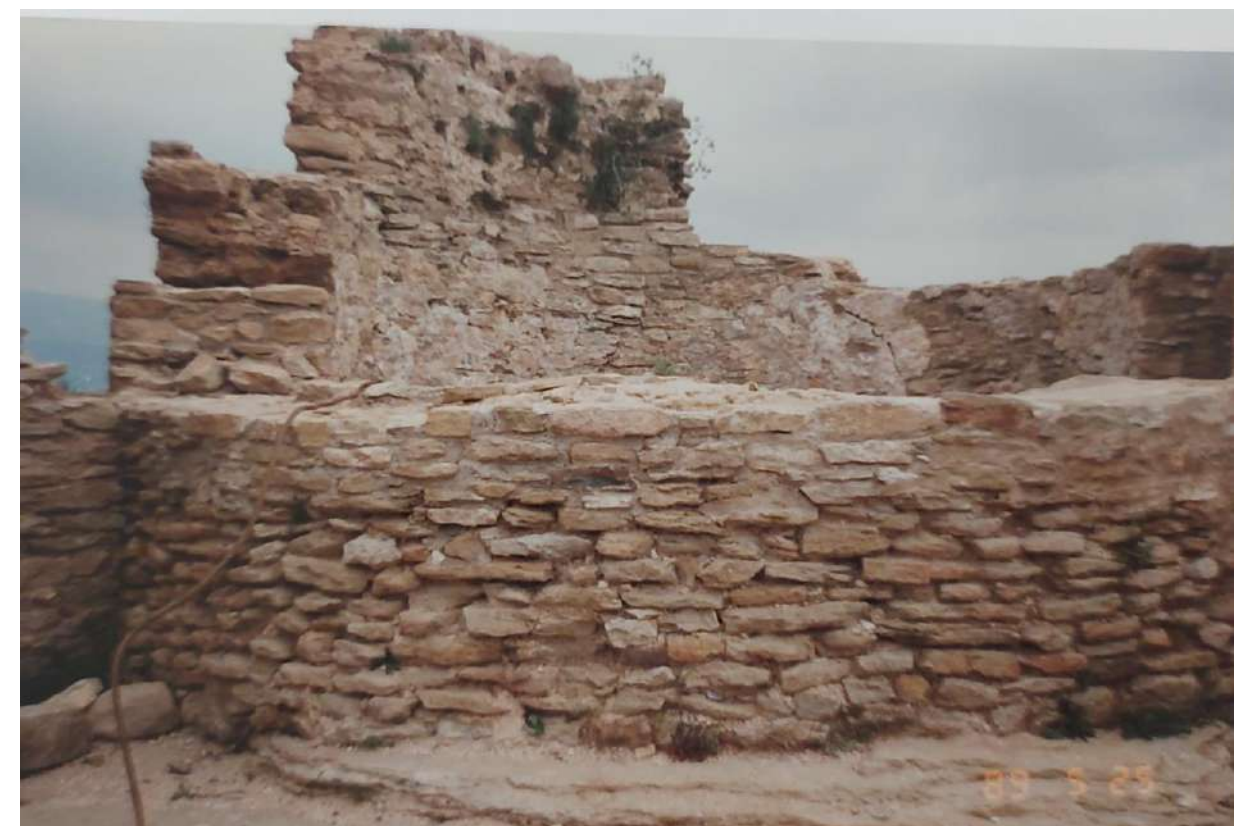
Figura 48. Torre restaurada, 1989. Font: Arxiu del Servei de Patrimoni de la Generalitat de Catalunya.
