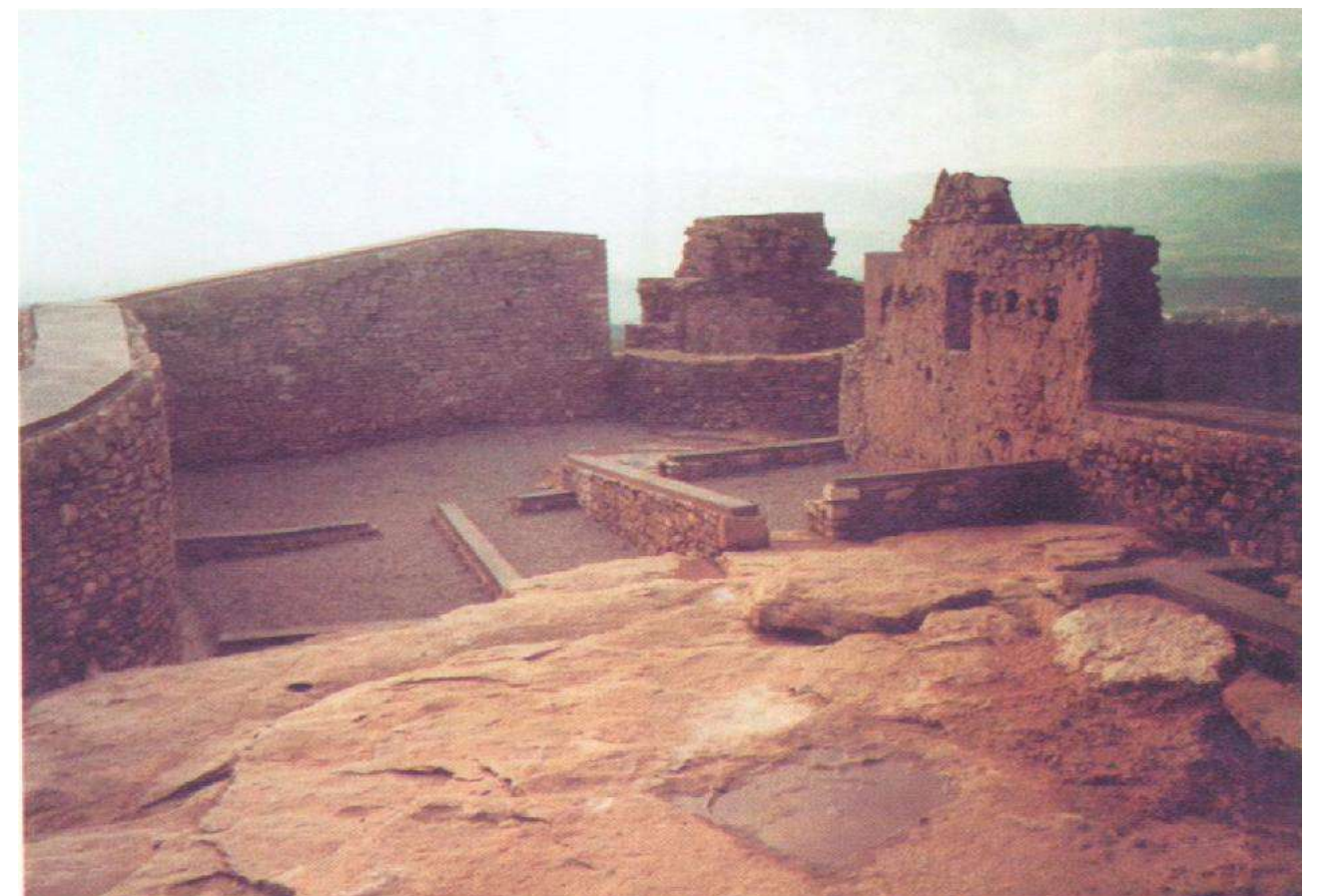
Figura 51. Torre restaurada, 1989 (Caballé i Ollich, 1989).
