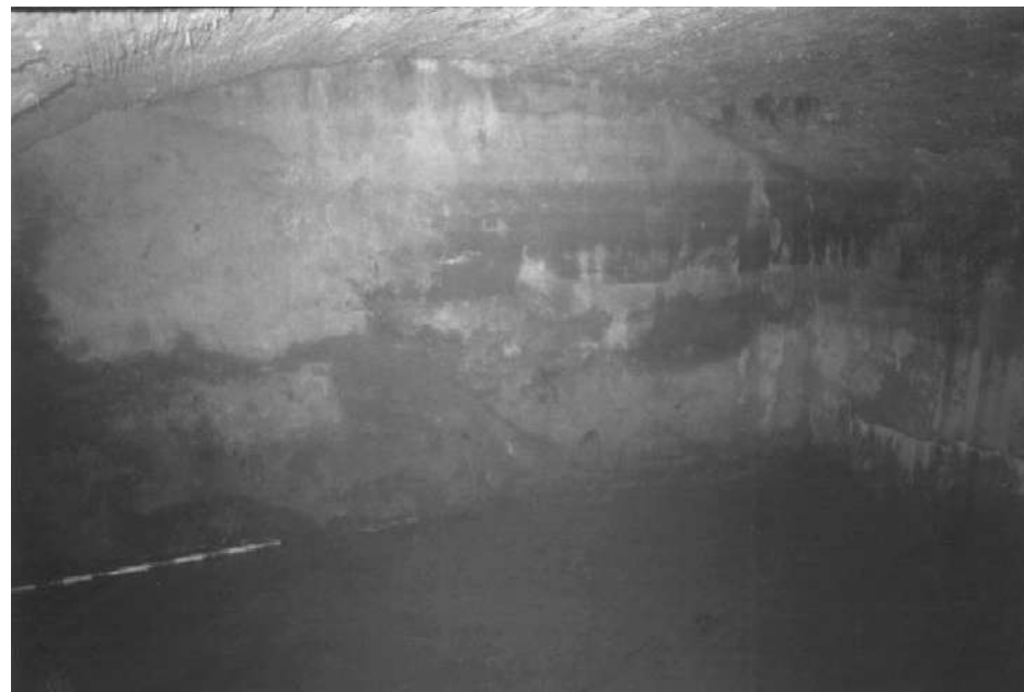
Figura 38. Interior de la cisterna (Caballé i Ollich, 1989).
