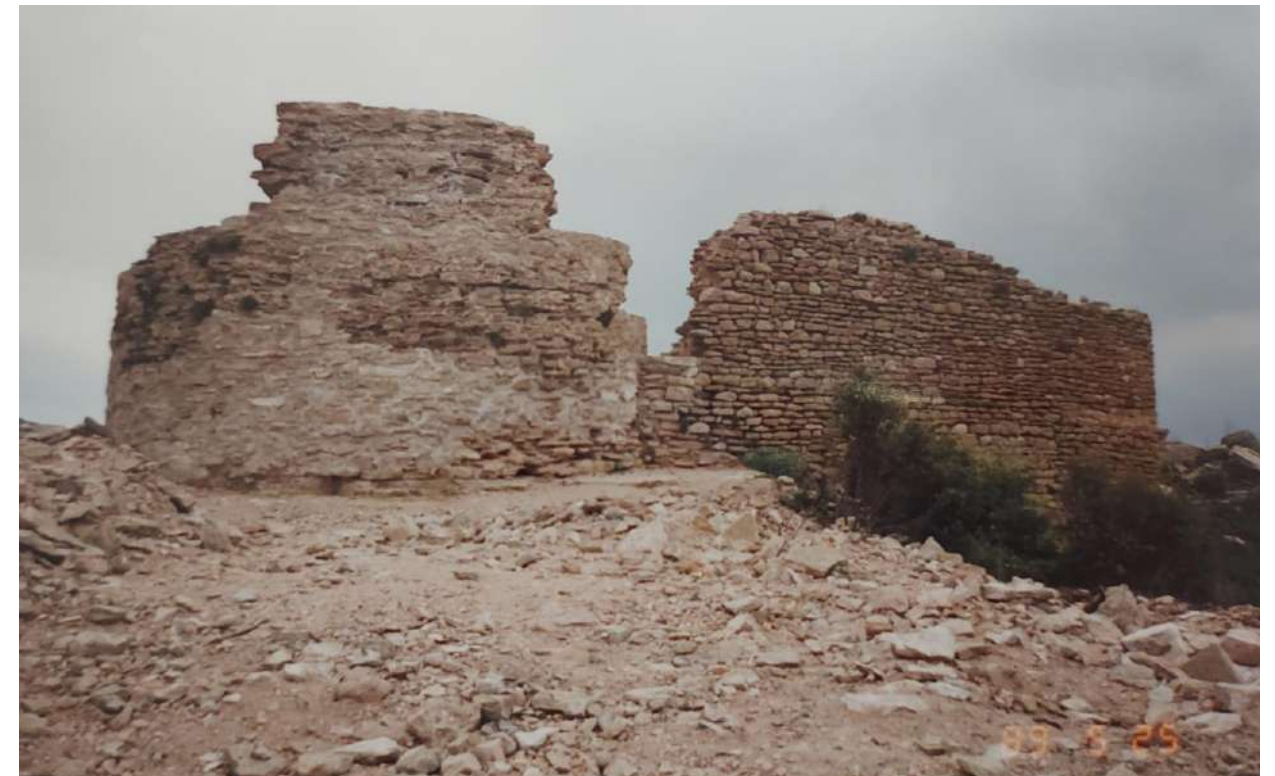
Figura 47. Torre restaurada, 1989. Font: Arxiu del Servei de Patrimoni de la Generalitat de Catalunya.
