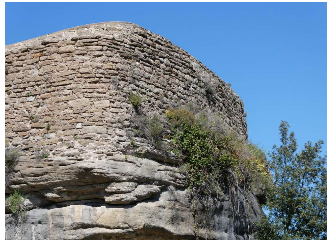
Figura 133. Vista de la cantonada exterior sud-est de la muralla (EMG, 2024).
