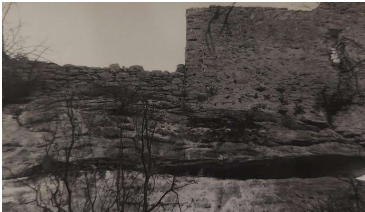
Figura 93. Discontinuitats (laminas) de la roca. Font: Arxiu del Servei de Patrimoni de la Generalitat de Catalunya. Document Signat electrònicament. Firmes vàlides. És còpia autèntica de l'original electrònic.
