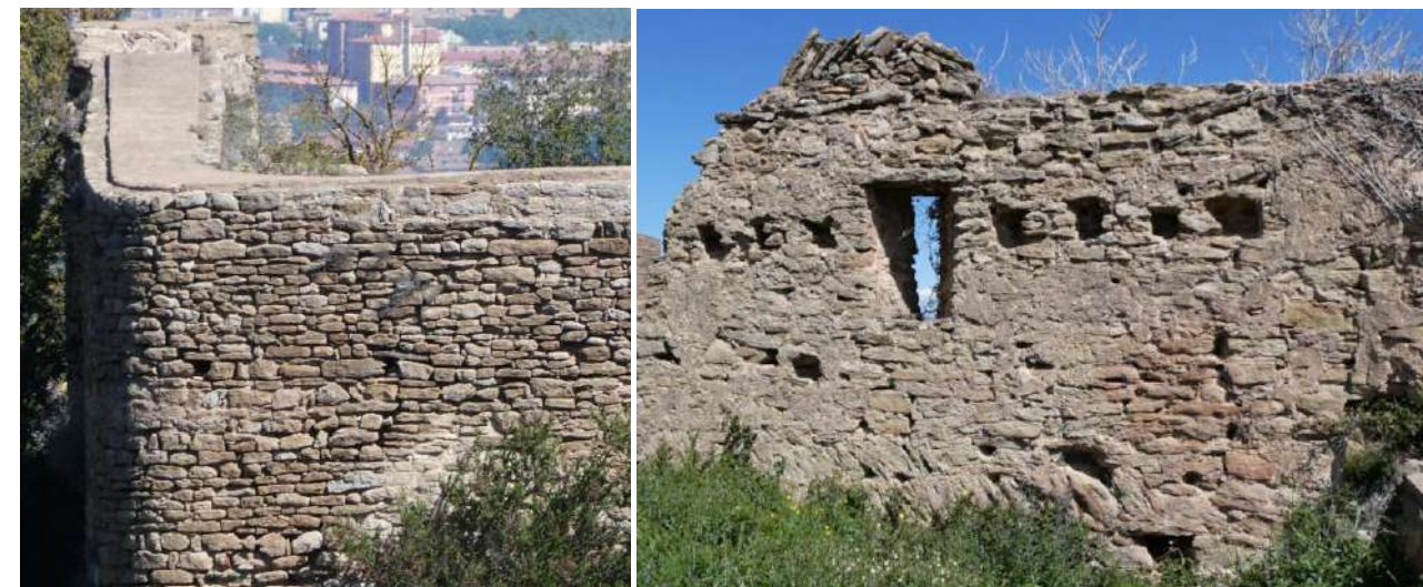
Figura 86. Cantonada sud-oest (a) i parament interior de la capella (b) respectivament (EMG, 2024).
