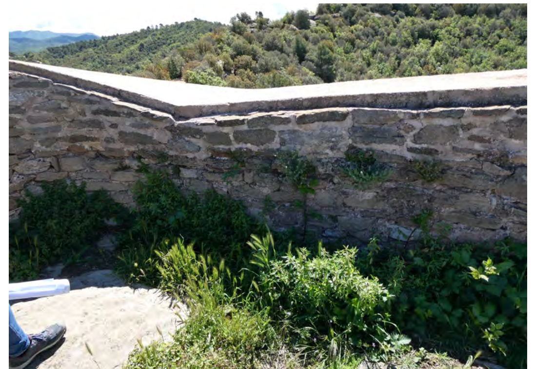
Vista de la cantonada interior sud-est de la muralla. Font: EMG,2024
