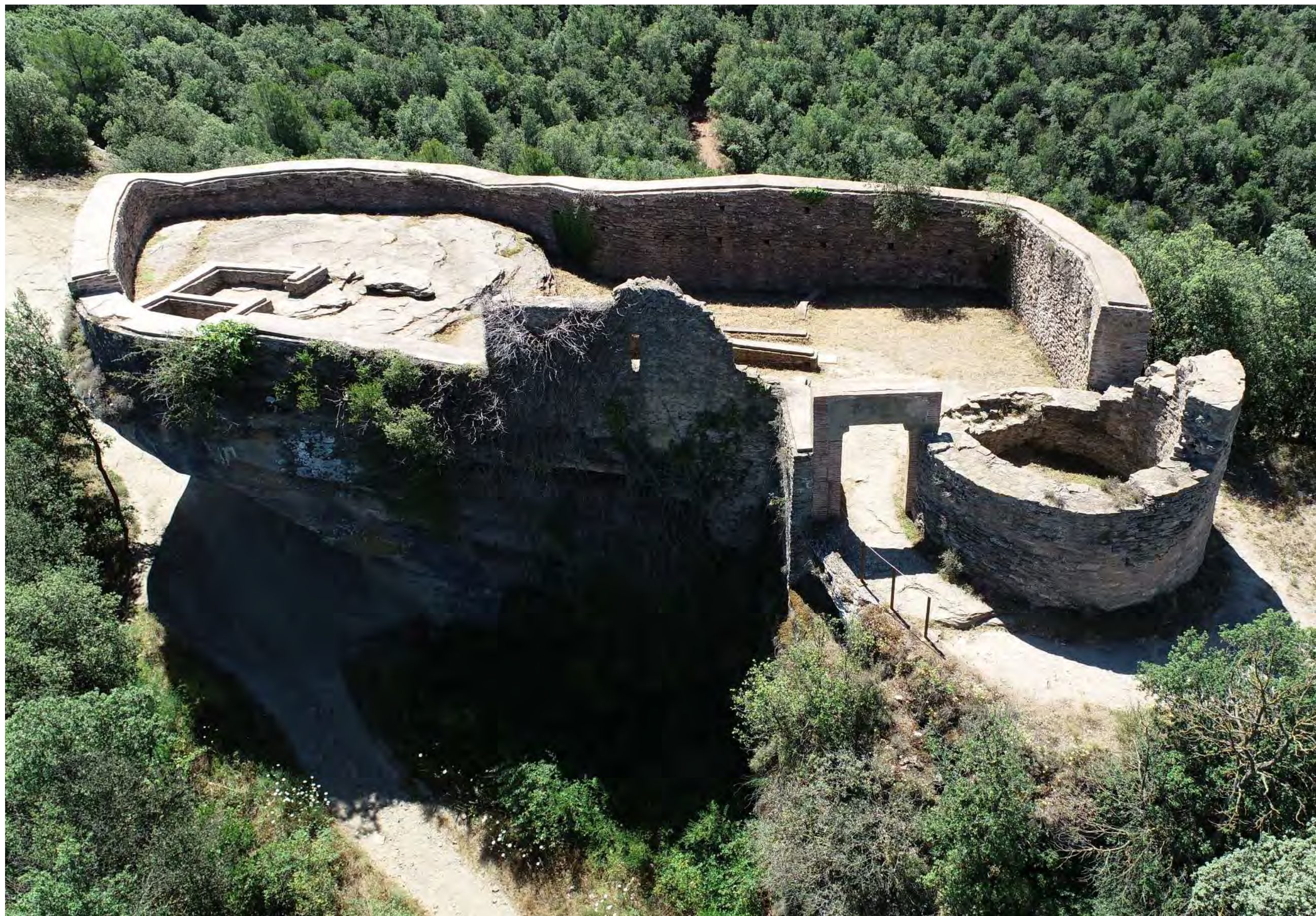
Vista aèria nord. Font: USGF, SPAL, 2024
