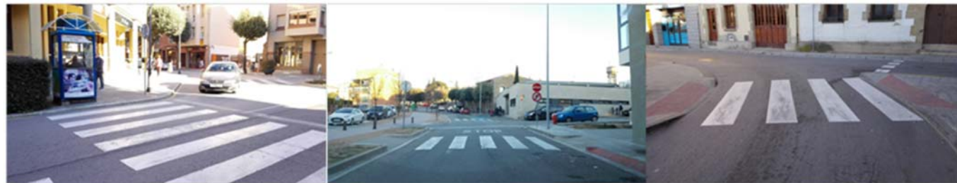
Figura 21. Pas no adaptat a la carretera de Mont Rodon. Pas practicable al passeig del Pujoló (manca senyalització per invidents i pavimentació vorera oest). I pas de vianants adaptat a la Plaça les Eres.
