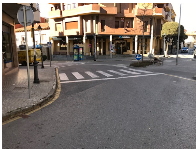
Vista al pas de vianants sense adaptar i al fons un altre pas de vianants interferit per la cabina ONCE
