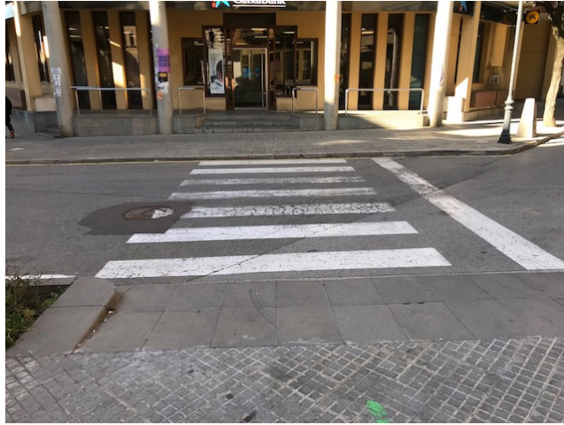
Vista al pas de vianants sense acabar en un costat
