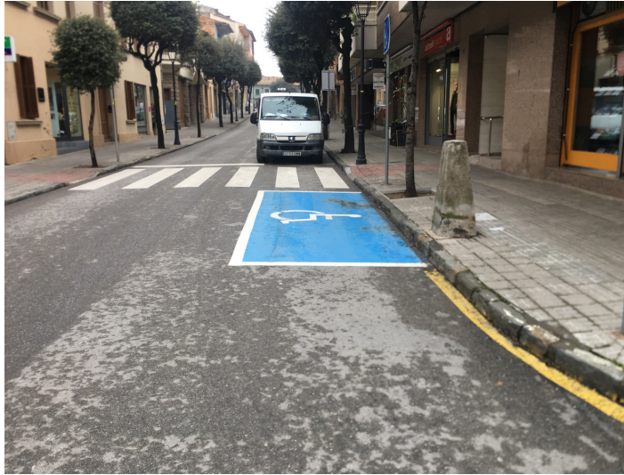
Vista al pas de vianants amb mala visibilitat i mal ubicat.
