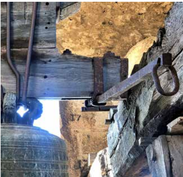
Palanca recta amb anella a la punta d'una campana de Sant Feliu de Pallerols
