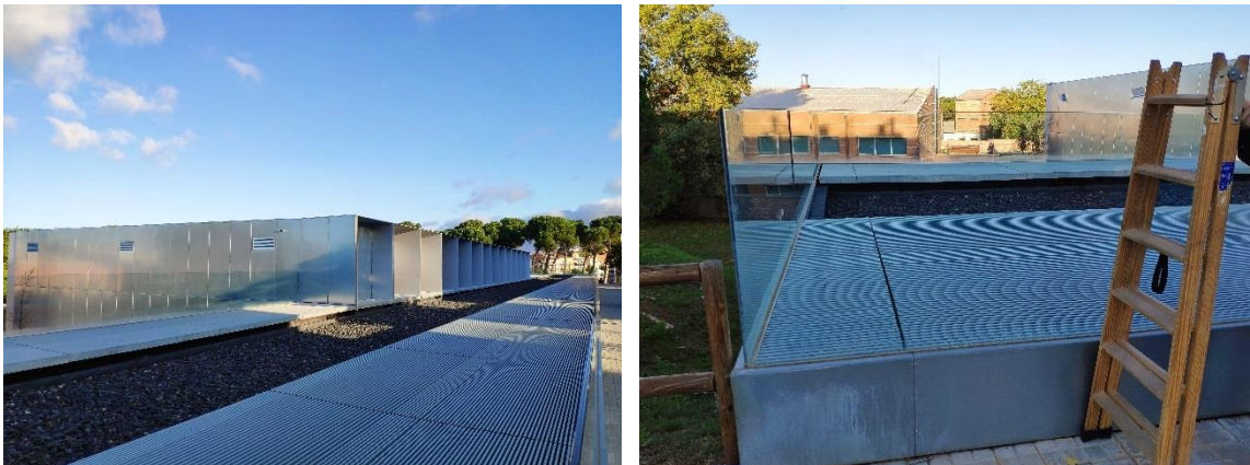
Figura 10 Detall accés a la coberta i necessitat de pas
