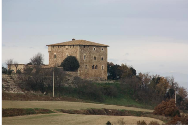
Il·lustració 20. Vista general del casal de Montrodon on es pot observar el desnivell del serrat i la pantalla vegetal existent que fa que des de nivell de terra no es pugui observar la zona d'estudi (Font: elaboració pròpia. Any 2023)
