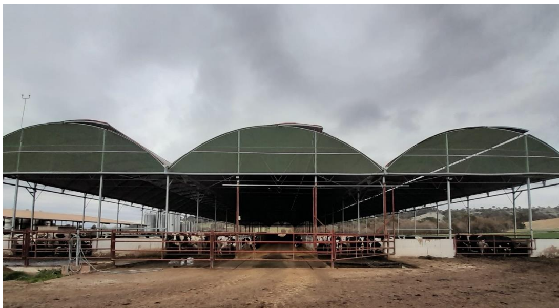
Il·lustració 42. Vista frontal de l'edifici 24-25 (Font: elaboració pròpia. Any 2023)
