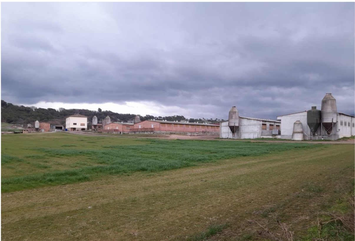
Il·lustració 36. Naus ramaderes existents en l'àmbit de la Modificació del Pla Especial de la Finca El Camp (Font: elaboració pròpia. Any 2023)
