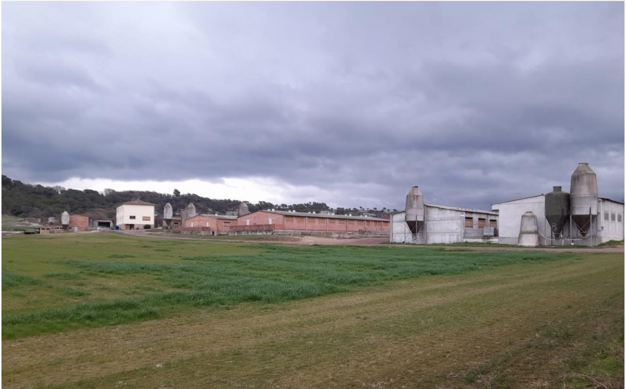
Il·lustració 12. Instal·lacions existents a l'àmbit de la Modificació del Pla Especial vigent (Font: elaboració pròpia. Any 2023)
