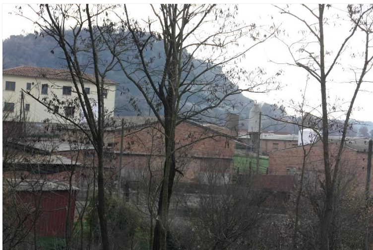
Il·lustració 13. Vista de l'explotació El Camp des de la part més pròxima de l'explotació El Gurri Gros (Font: elaboració pròpia. Any 2023)
