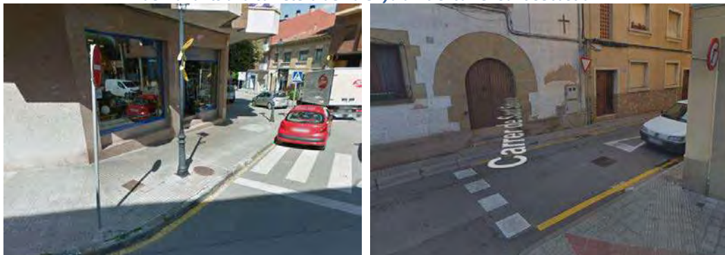
Figura 25: Pas de vianants no accessibles a la carretera Mont Rodon amb el carrer Domènec Sert i manca de pas de vianants a la carretera de Balenyà amb el carrer Sant Sebastià
