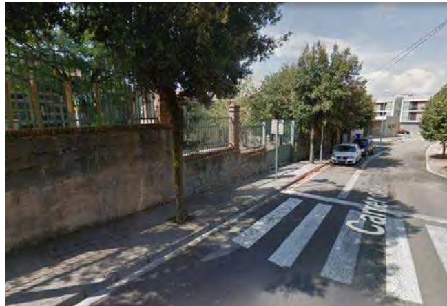
Figura 28: Pas de vianants no accessibles al carrer Ramon Pou a la intersecció amb el carrer Francesc Camprodon
