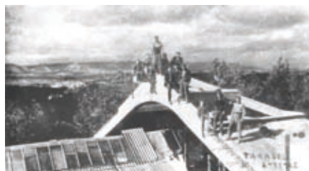
Construint la nova nau a sobre de l'antiga Un moment de la construcció
