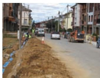
Execució de les obres
