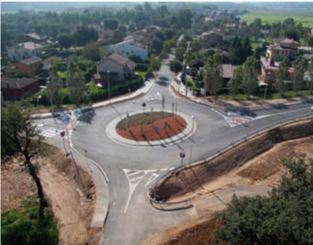
Vista aèria de la rotonda
