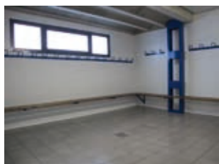
Estat actual dels vestidors
