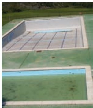
Estat de la piscina abans de les obres
