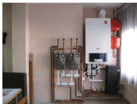
Nova instal·lació de calefacció
