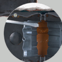
Romper las paredes intermedias para instalar los mecanismos
