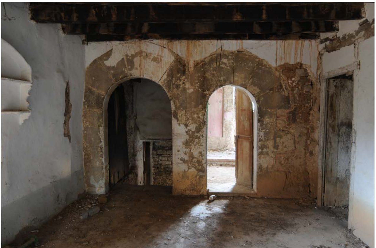
Portes de la sala del primer pis, a l'esquerra, l'escala, i a la dreta la cambra principal de la torre.
