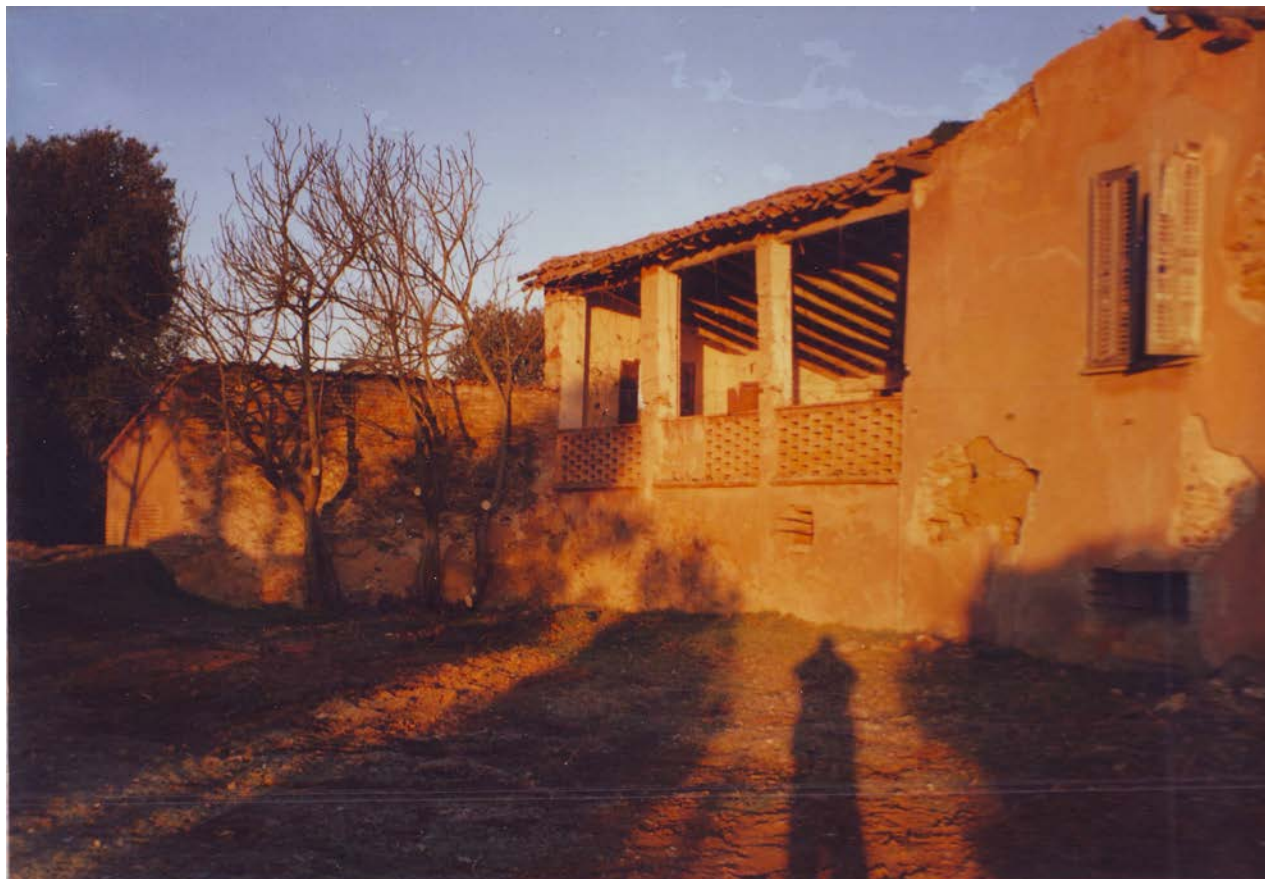
La solana, el 1998, a l'inici de les obres.
