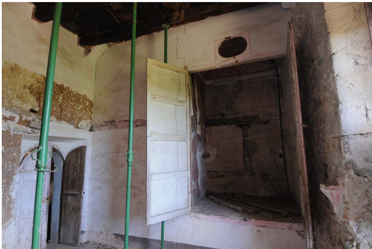
Cambra principal de la torre, amb la capella.
