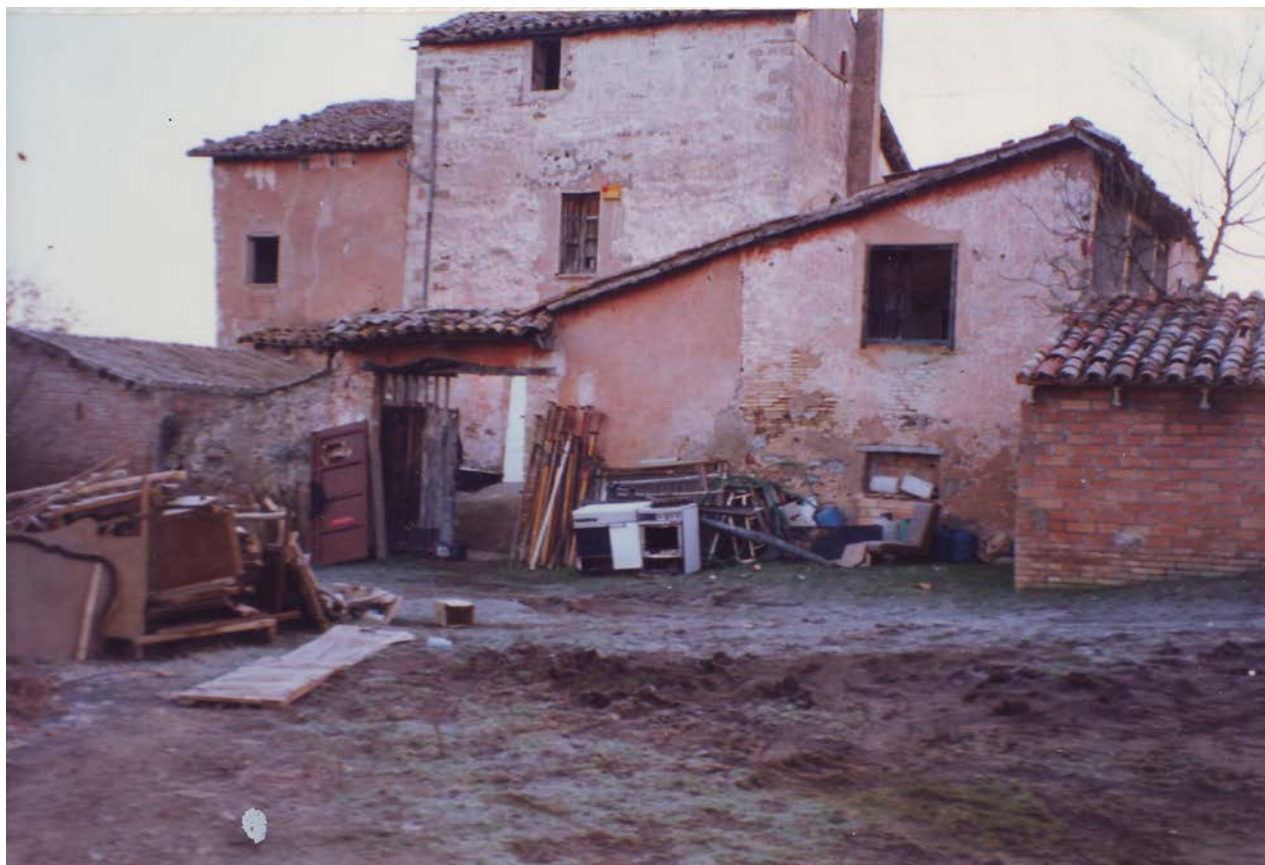
El Mas el 1998, en l'inici de les obres. S'hi observa el tancament del pati d'entrada, i els cossos laterals
