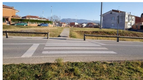
Imatge 52. Detall del pas de vianants.
