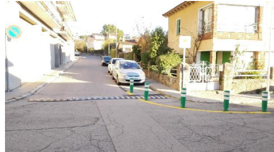
Imatge 65. Pilonos per evitar l'estacionament al pas. Bona pràctica per alliberar visibilitat al carrer de la Vila.
