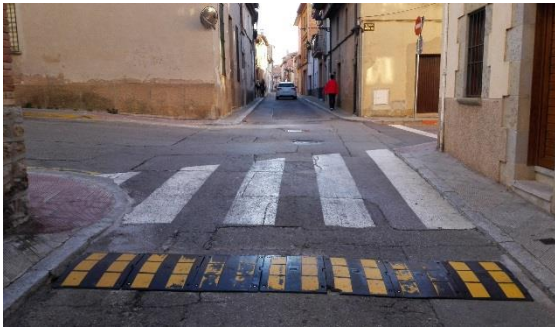
Imatge 29. Bandes prefabricades al carrer de la Vila.
