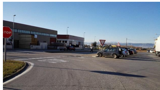
Imatge 42. Accés a la gasolinera sense marques vials
