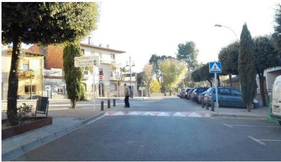
Imatge 16. Pas de vianants amb vorera contínua al passeig de Sant Genís.
