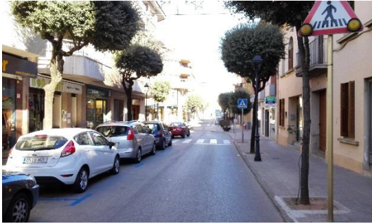
Imatge 18. L'estacionament de vehicles davant del pas de vianants dificulta la visibilitat.
