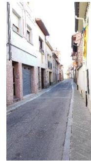
Imatge 17. Vorera amb amplada de pas insuficient al carrer de la Vila.
