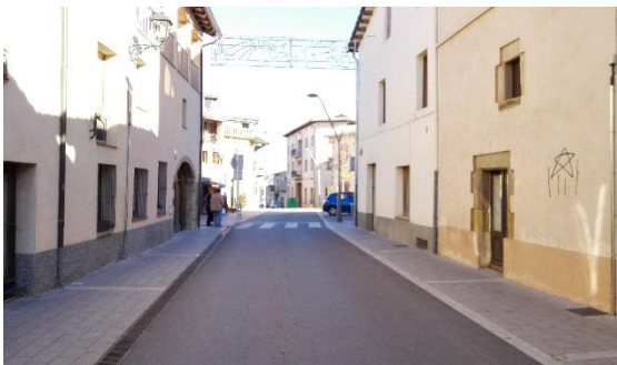
Imatge 12. Carrer de la Font amb plataforma única i espai per a vianants diferenciat.
