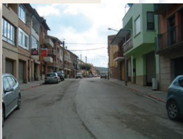
Avinguda de Castellet on s'observen línies elèctriques que travessen
