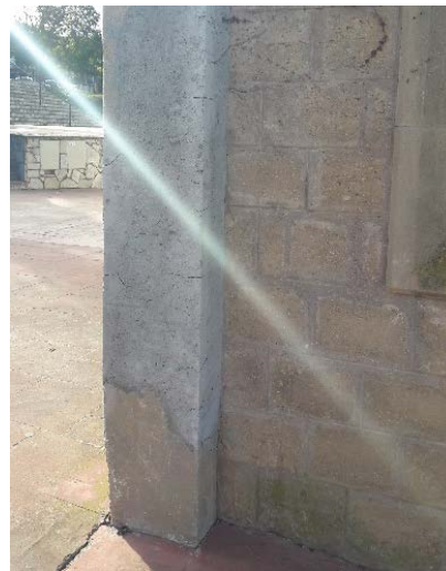
Pilar pòrtic amb morter provisional
